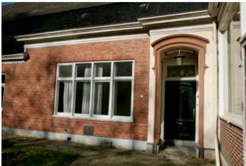
Afb. 50. Linkerzijgevel met entree naar de hals en links het venster waarbij de bovenkant is aangepast kort vóór 1949. Let op de aflopende laag onder dit venster die verder doorloopt. Foto: Auteur.
