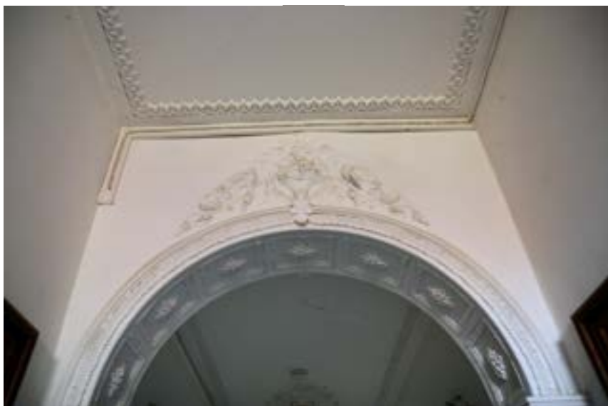
Afb. 64. Detail stucwerk rondboog naar achteren gezien. Foto: Auteur.
