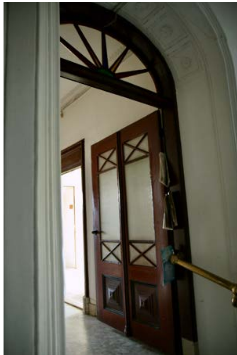
Afb. 70. Middengang gezien vanuit dwarsgang naar voren. Foto: Auteur.
