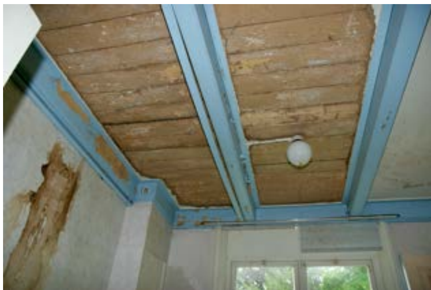
Afb. 89. Kantoortrek met balkenplafond en achter de latere kartonplaten nog de originele okerleurige afwerking. Foto: Auteur.
