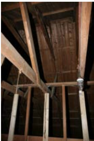
Afb. 27. Kapconstructie hals. Foto: Auteur.
