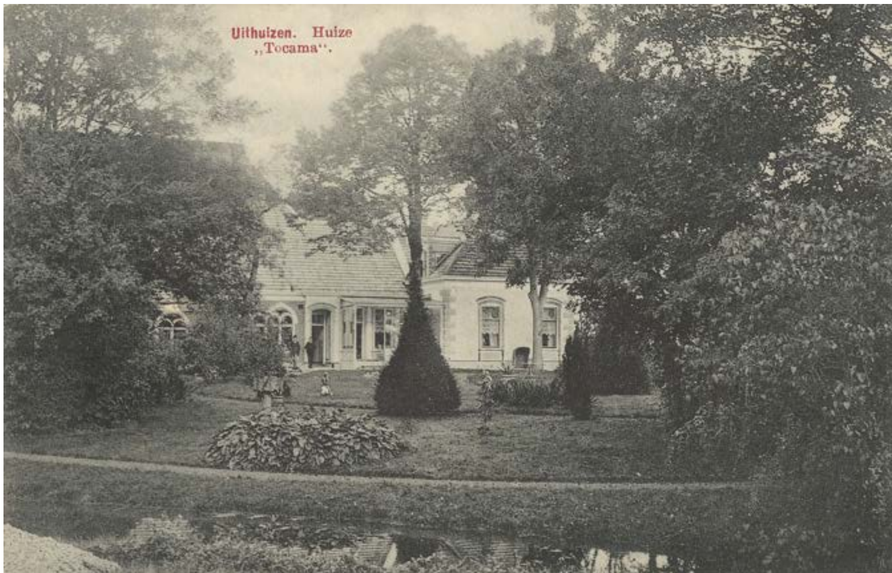
Afbeelding: ansichtkaart Uithuizen. Huize "Tocama". Uitgever Eckhardt's Bazar bron 1986_17226.jpg collectie Groninger Archieven. Bouwfase, na 1909 en voor 1915. Schuur daklijn riet hoog. Tuin is dan nog intact. Dubbel rondboogvenster naast hoofdzijentree. Links nog een rondboog venster. Serre met linker stuk open als doorgang. Linker wand van glas met kruispatroon eronder. Serre niet voorbij linkerzijgevel dwarshuis. Tuin met beelden en drie rondlopende paden. Mensen poseren.
