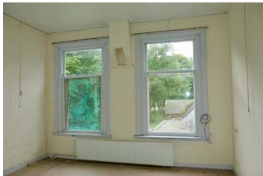
Afb. 106. Dwarshuis verdieping, linker slaapkamer naar achteren gezien. Doorvoer verwarming. Foto: Auteur.
