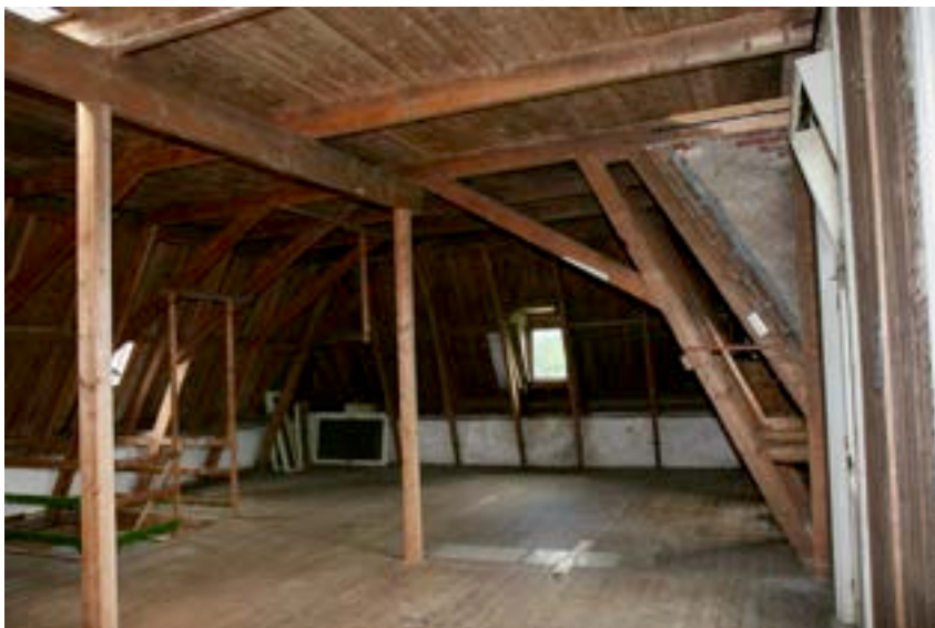
Afb. 25. Kapconstructie dwarshuis naar rechts gezien met onderslagbalk ter plaatse van de gemetselde kajuit. Foto: Auteur.
