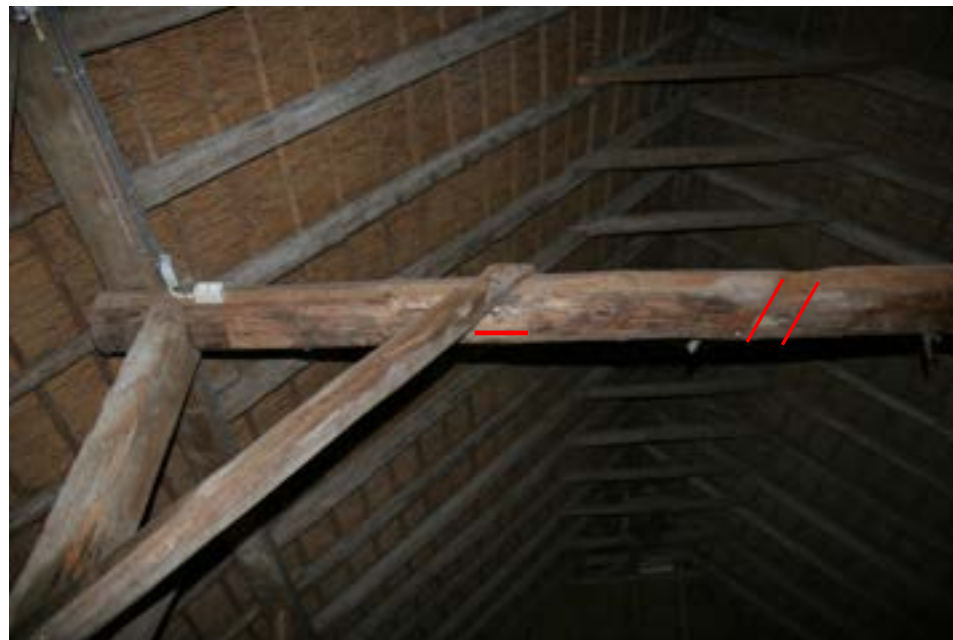
Afb. 127. Bijschuur 7e gebint met in rood, links het oude pengat van de staander en rechts van het korbeel. Foto: Auteur.
