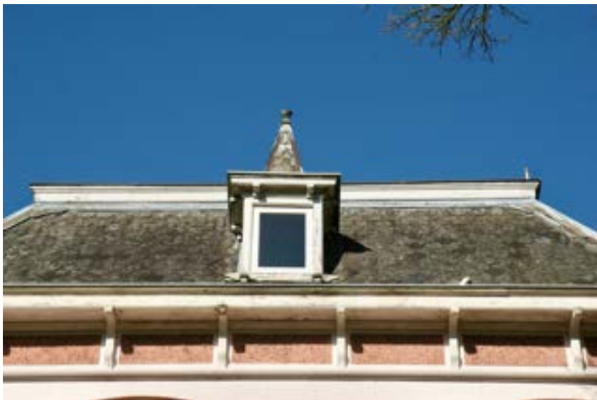
Afb. 22. Dak dwarshuis met leien gedekt met dakkapel. Foto: Auteur.
