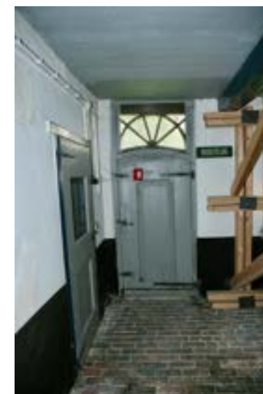
Afb. 43. Bijschuur voor. Toegang van voorgevel. Foto: Auteur.
