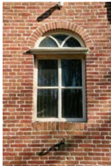
Afb. 55. Venster achtergevel hoofdschuur. Foto: Auteur.
