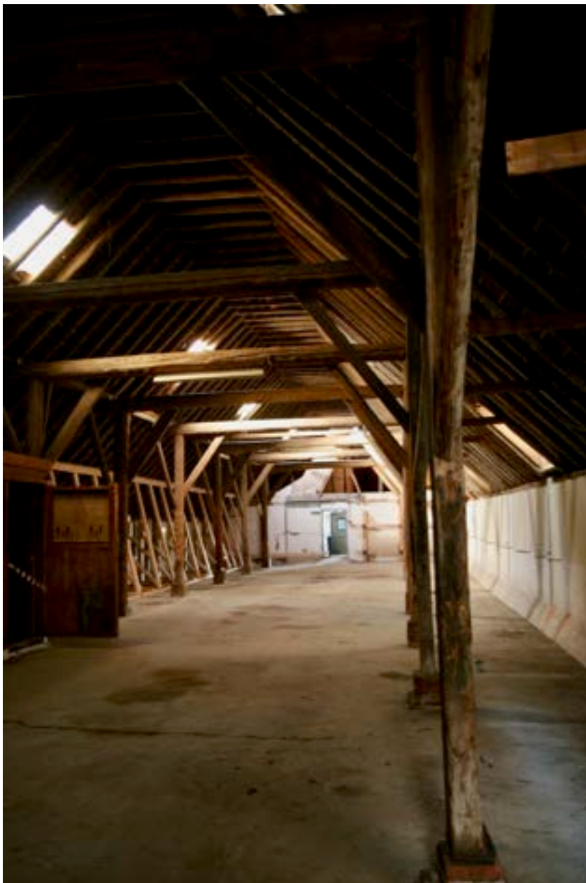
Afb. 126. Bijschuur, naar voren gezien. Foto: Auteur.
