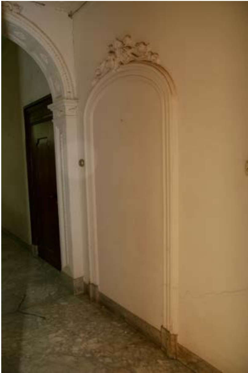
Afb. 67. Begane grond middengang stucwerk tegenover verdiepingstoegang met daarnaast de dichtgezette deur. Foto: Auteur.
