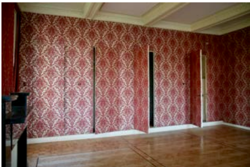
Afb. 72. Dwarshuis linker kamer, bedsteewand met daarboven omstuukte balken. Foto: Auteur.
