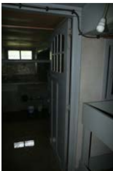
Afb. 30. Kelder naar voren gezien met deur 1913. Foto: Auteur.
