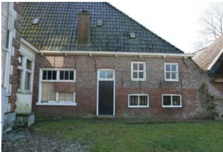
Afb. 56. Overzicht voorgevel hoofdschuur met horizontale bouwnaad. Foto: Auteur.
