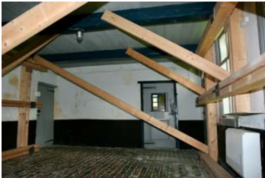
Afb. 95. Bijschuur voor, linker vertrek. Gezien naar rechts. Links de toegang naar de bijschuur. Rechts naar de stookruimte. Foto: Auteur.
