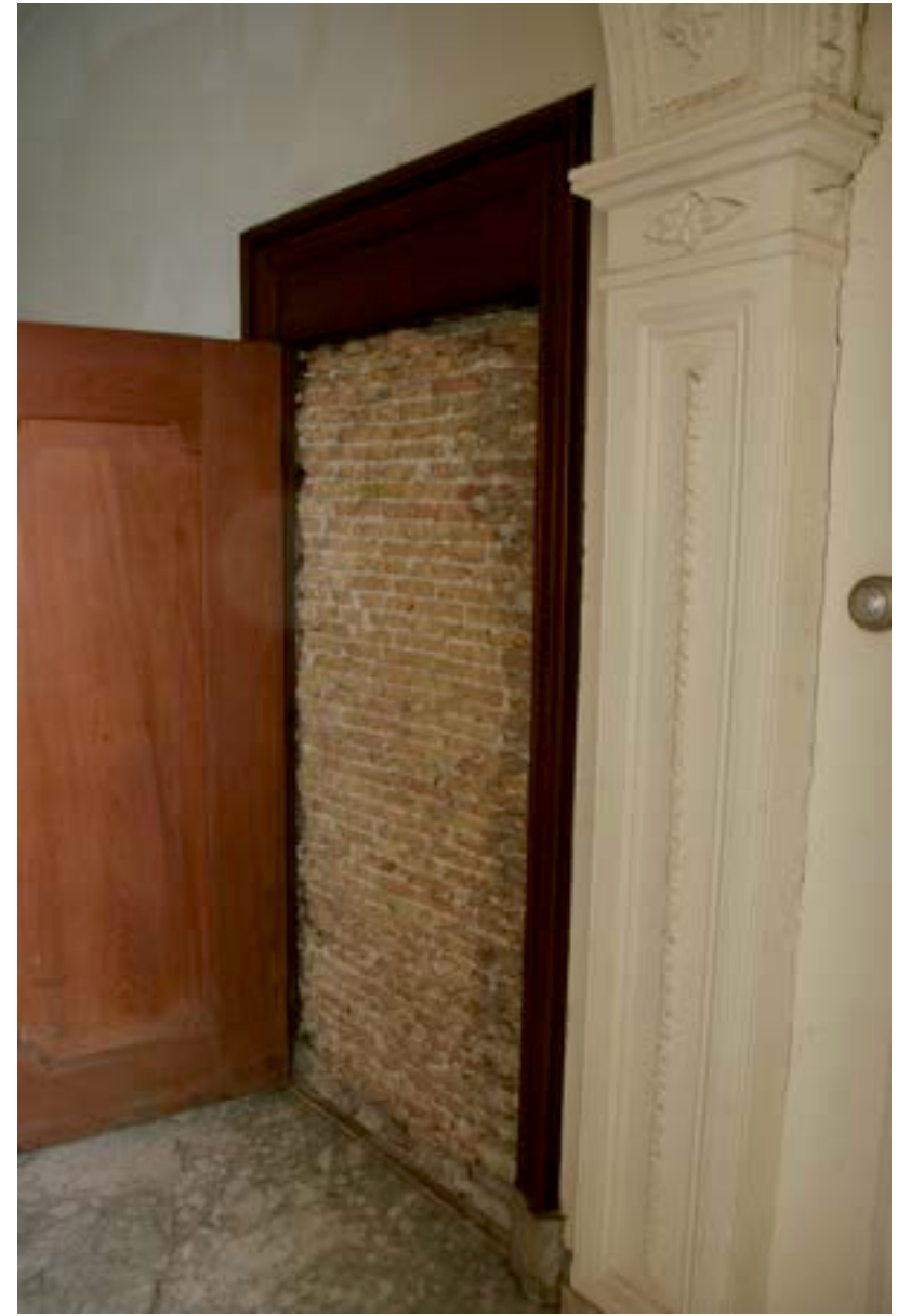
Afb. 68. Begane grond middengang. Later dichtgezette doorgang tbv een kluis aan de andere kant. Foto: Auteur.
