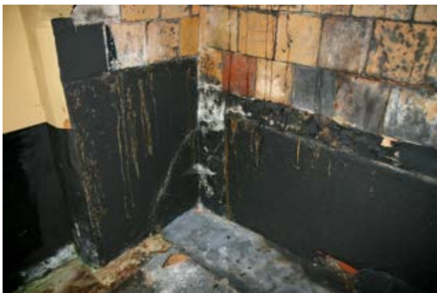
Afb. 101. Bijschuur voor, rechter vertrek. Detail stookplek met gietijzeren plaat op grond en wand met daarboven gele plavuizen. Foto: Auteur.
