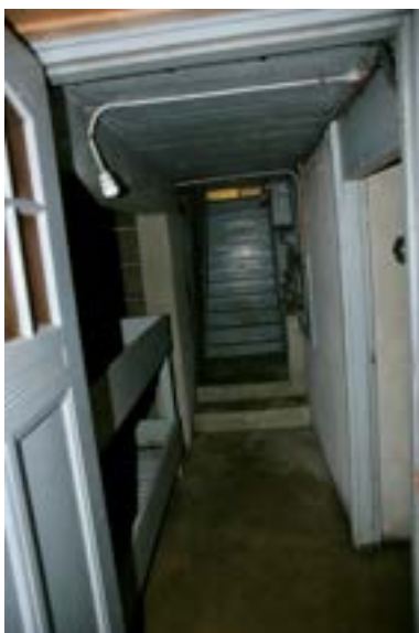
Afb. 29. Kelder naar achteren gezien, met trap. Foto: Auteur.
