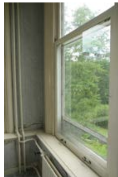
Afb. 112. Verdieping venster met voorzetraum. Foto: Auteur.
