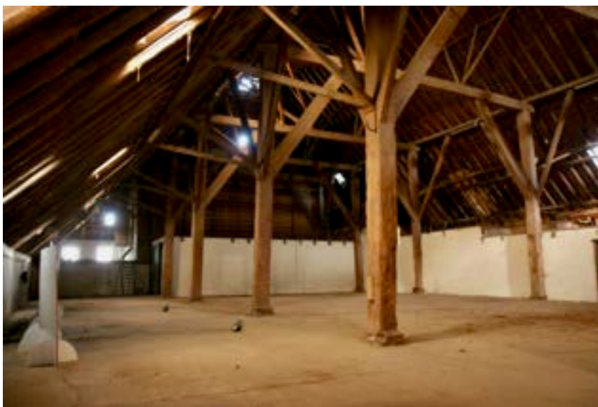
Afb. 114. Overzicht deelzijde hoofdschuur naar voren gezien. Foto: Auteur.
