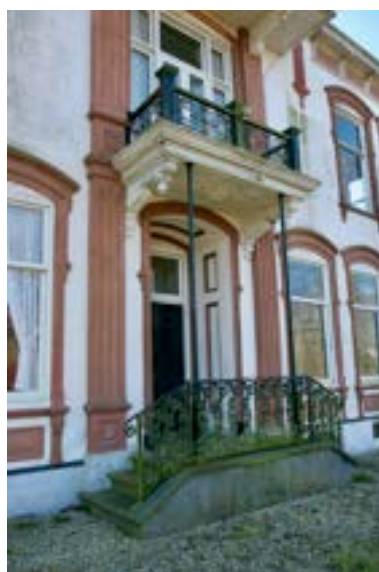
Afb. 48. Detail entree voorgevel. Foto: Auteur.
