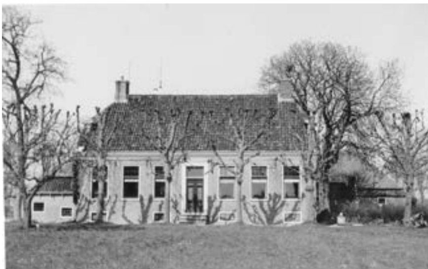
Afb. 36. Boerderij Papekop 1920-1940, dwarshuis met deels onderkelderd voorhuis, gebouwd in 1817 volgens jaartal in de neuten van de entree. Foto: Bron 818_21270.jpg collectie Groninger Archieven.
