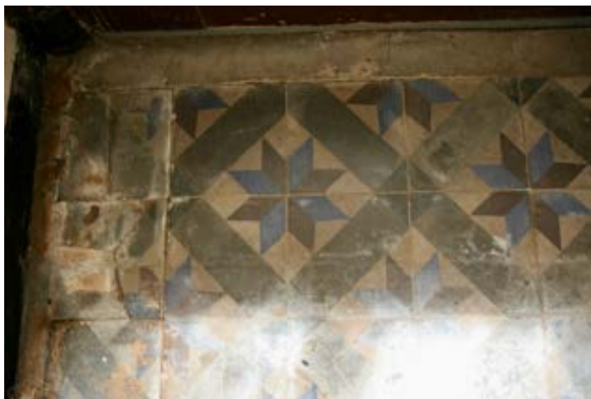
Afb. 9. Tegelvloer achter entree dwarshuis. Hoe kleurrijk was de rest van het interieur? Foto: Auteur.
