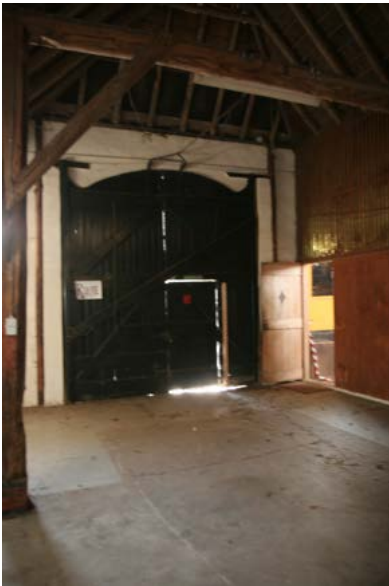
Afb. 128. Overzicht deeldeuren bijschuur naar achteren gezien. Foto: Auteur.
