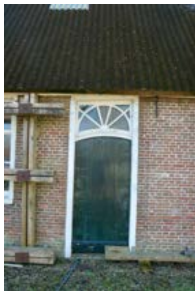
Afb. 58. 18 e eeuwse bovenlicht bijschuur. Foto: Auteur.
