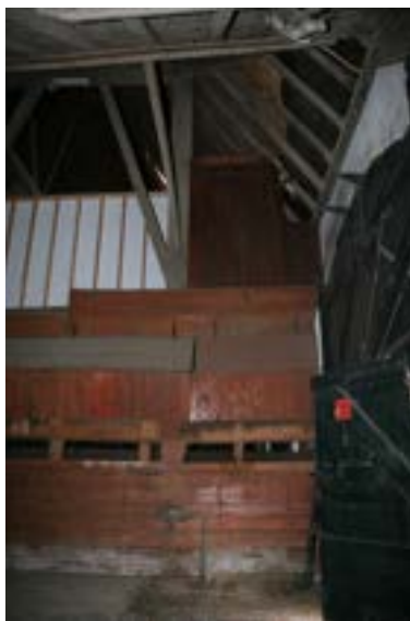
Afb. 121. Hoofdschuur achterdakschild. Foto: Auteur.
