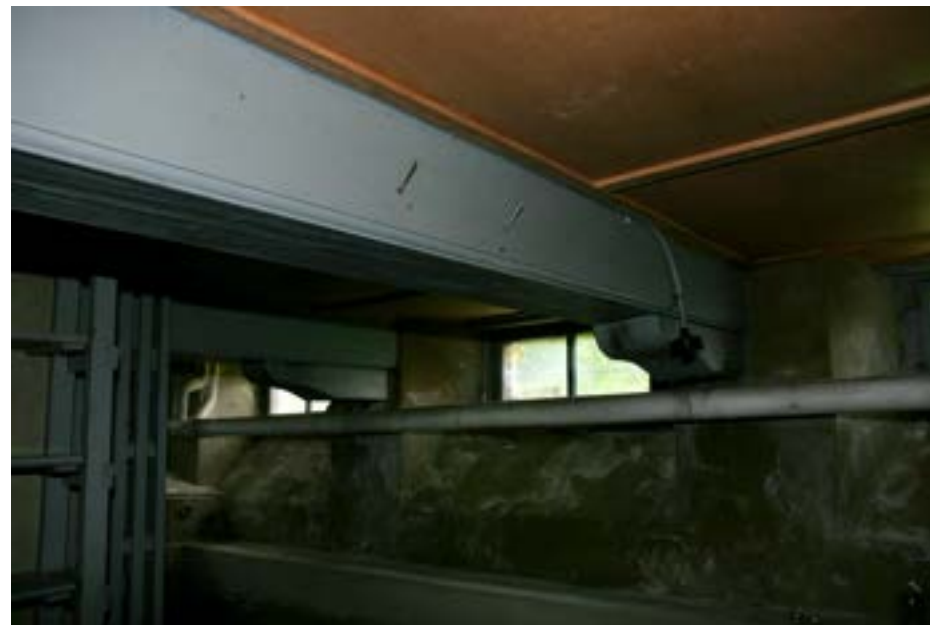
Afb. 31. Kelder naar voren gezien met balklaag met sloffen. Foto: Auteur.
