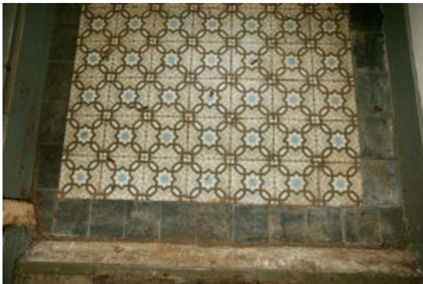
Afb. 88. Kantoorgang, tegelvloer achter voorste zijingang linkerzijgevel. Foto: Auteur.
