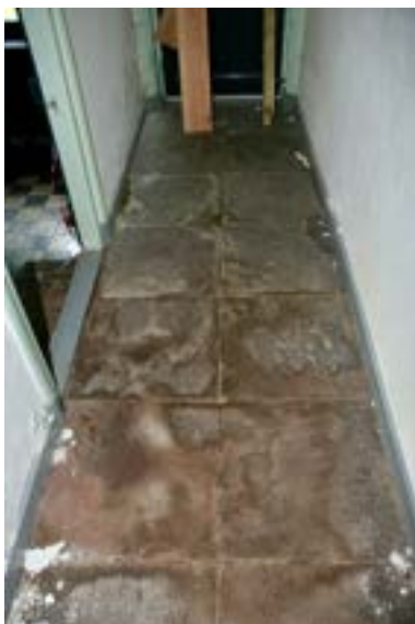
Afb. 91. Hoofdschuurgang naar voorgevel. Foto: Auteur.
