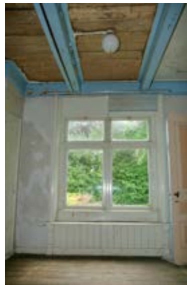
Afb. 87. Venster met originele omtimmering. Foto: Auteur.
