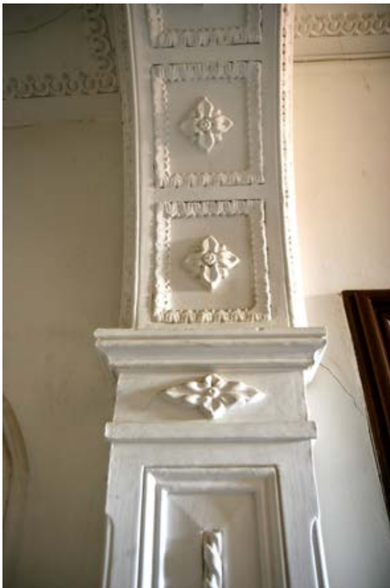
Afb. 129. Gestuukte rondboogdoorgang middengang door de achterwand van het dwarshuis. Foto: Auteur.
