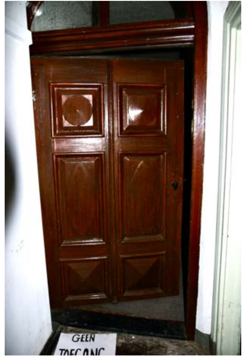
Afb. 81. Drie-paneels deur in dwarsgang vermoedelijk omstreeks 1850. De wand van de bijkeuken sluit hier niet mooi op aan. Foto: Auteur.
