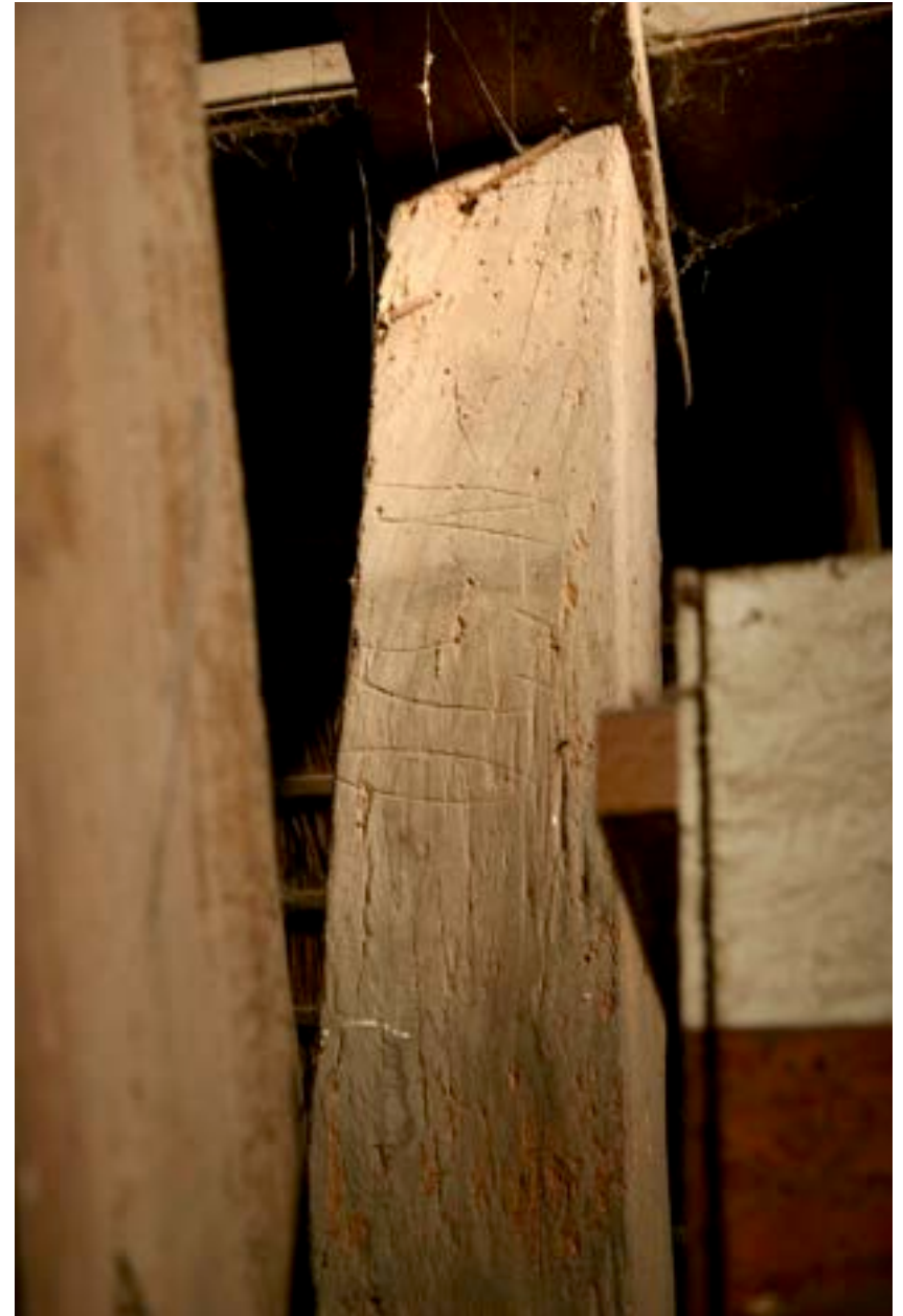
Afb. 125. Merkteken op binnenkant staander 8° gebint. Foto: Auteur.
