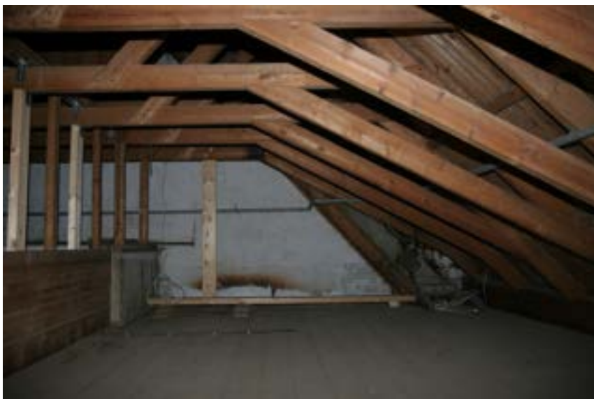
Afb. 26. Kapconstructie hals naar voren gezien. Foto: Auteur.
